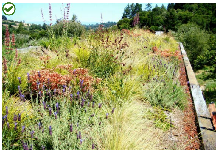
Toiture plantée - substrat 15 à 25 cm
