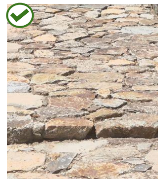
Pavage de granite sur lit de sable
